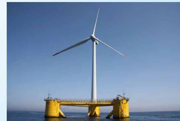
Actual parque eólico marino en la costa norte de Portugal.
